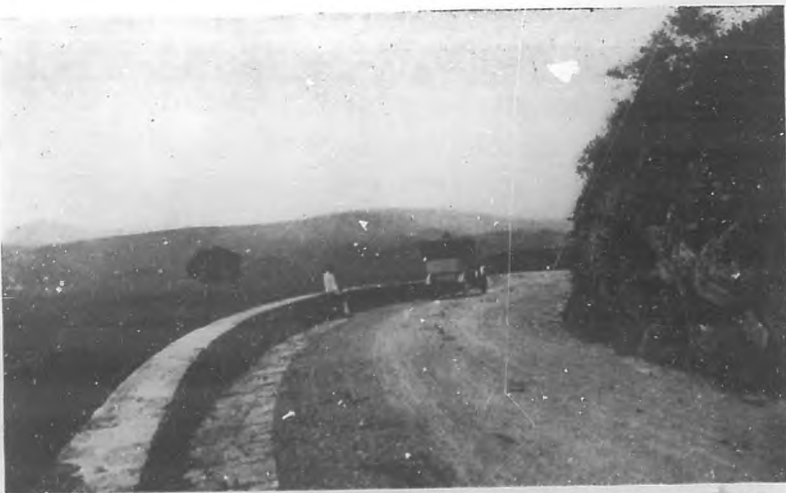
Un aspecto de la carretera del Puerto de Boniato, admirable obra que perpetúa, en Cuba, la grata memoria del general Wood.
